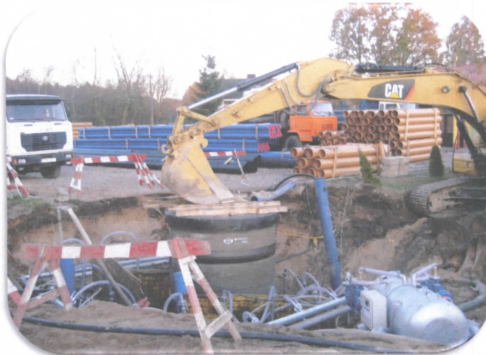
Fotografia nr 4: Budowa sieci kanalizacyjnej na terenie gminy Sławno. Źródło: Urząd Gminy w Sławnie
